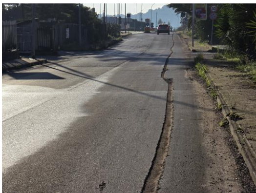
Solchi/cicatrice tortuosa e posa in opera di cls non a raso
