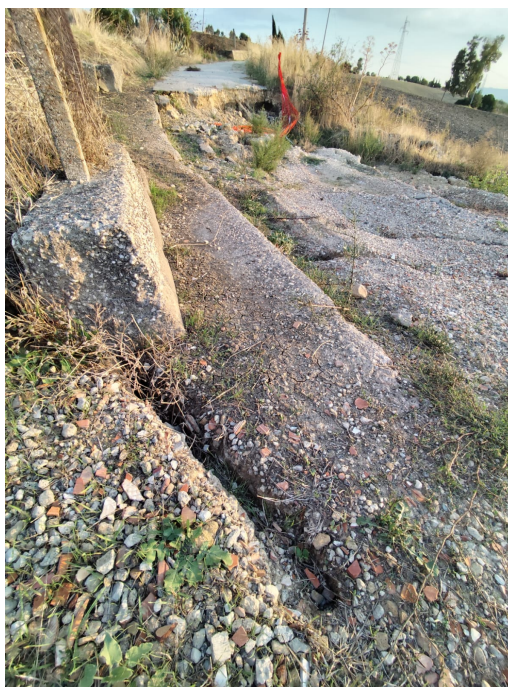
Foto 08 - Dissesti e fratture in prossimità della strada
