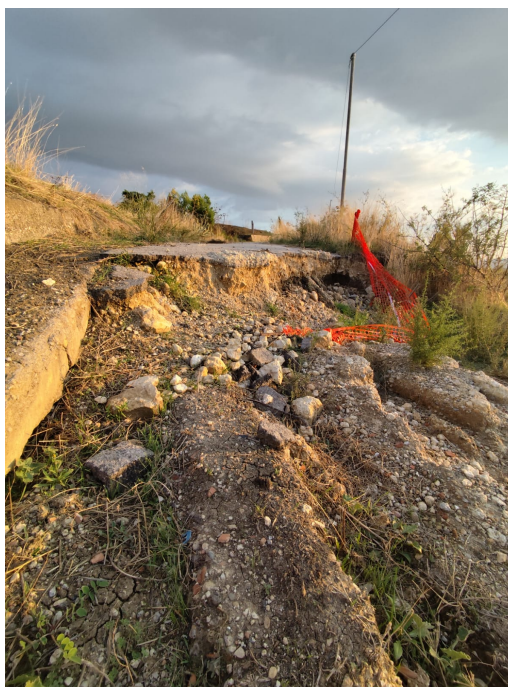
Foto 10 - Sezione della carreggiata compromessa e segnalazione precaria
