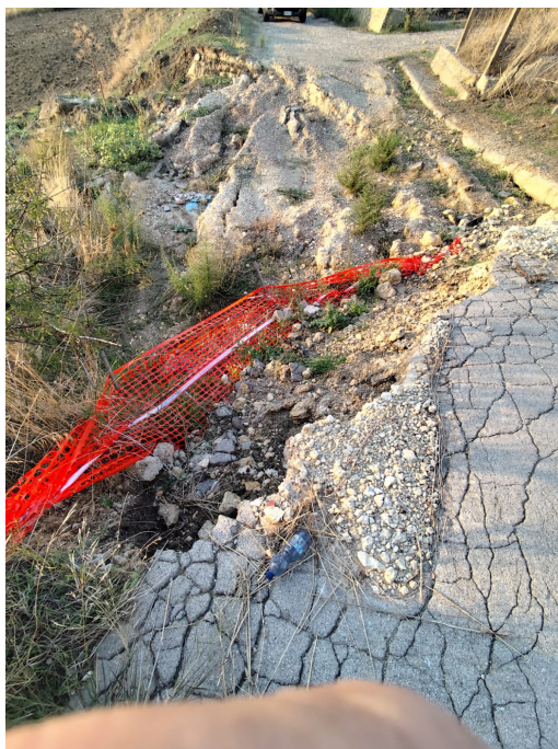
Foto 04 - Cedimento in corrispondenza del margine della sede viaria
