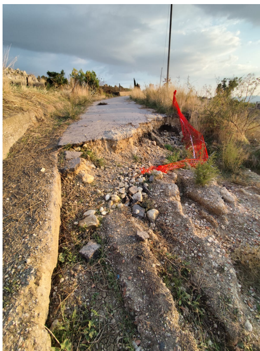
Foto 04 - Cedimento in corrispondenza del margine della sede viaria
