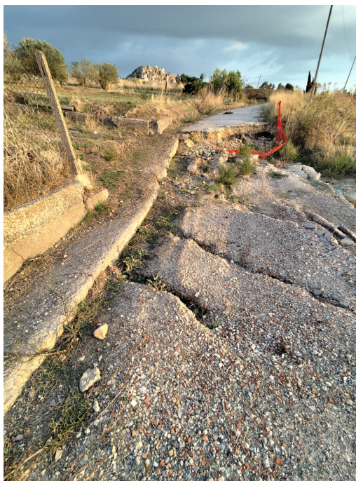
Foto 10 - Sezione della carreggiata compromessa e segnalazione precaria
